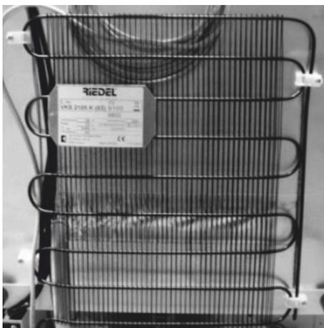
Über den Verflüssiger (Kondensator) wird die anfallende Wärmeenergie an die Umgebungsluft abgegeben.
